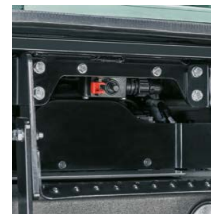
Butonul de deconectare a bateriei este situat pe treapta de acces în stânga.
